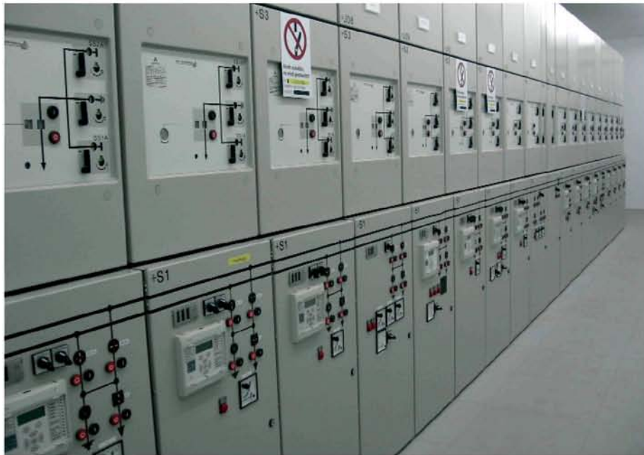
20 kV-SF 6 -Schaltanlage
