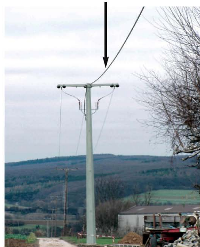
20 kV-Freileitung – isoliert
