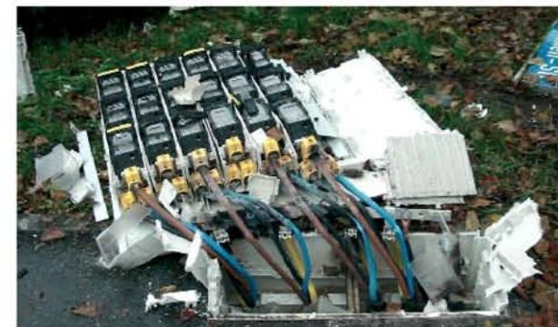
Umgefahrener Kabelverteiler
