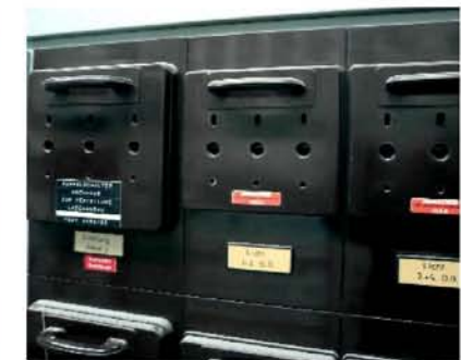
Lasttrennschalter mit NH-Sicherungen
