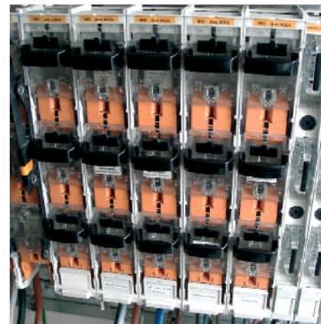
Lasttrennschalter mit NH-Sicherungen
