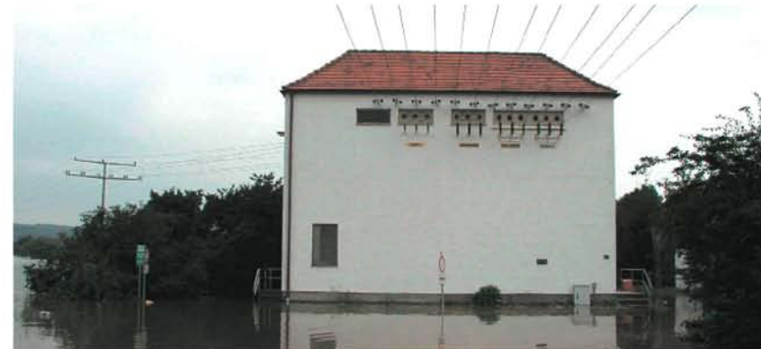
Überflutete Mittelspannungsschaltanlage
