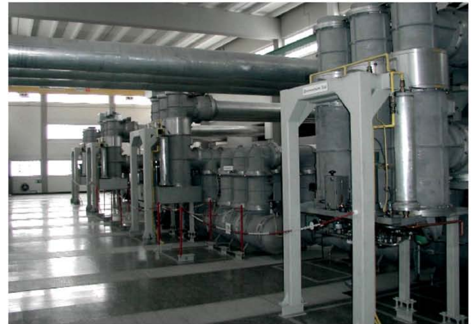
110 kV-SF 6 -Schaltanlage
