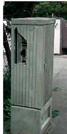
Beschädigter Kabelverteilerschrank
