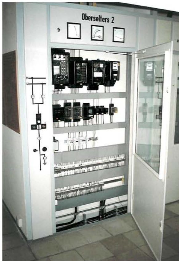
Netzschutz elektromechanische Ausführung
