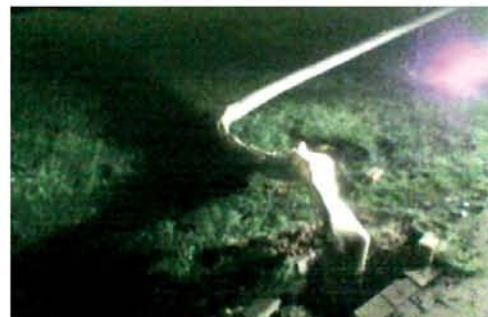
Umgefallener Straßenbeleuchtungsmast noch in Funktion
