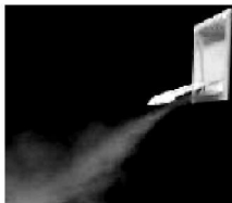
Luftleitung in den Tierbereich
